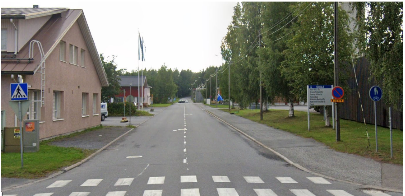
Kuva 21. Yrittäjänkadun pohjoisreunassa on yhdistetty jalankulun ja polkupyörän väylä. (Kuvälähde Google Maps)
