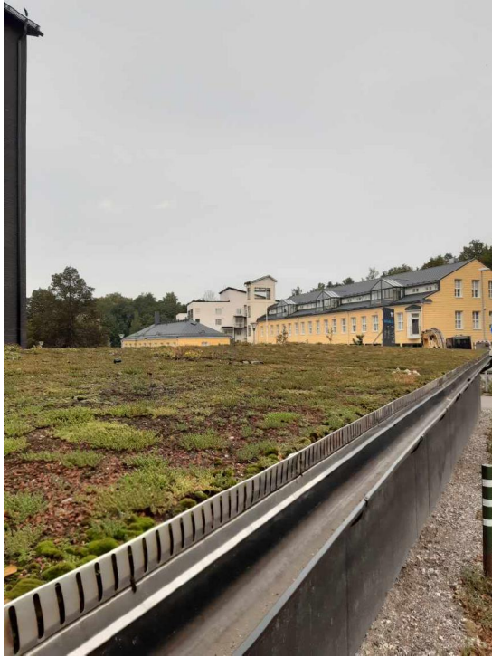
Kuva 8. Esimerkki viherkatosta (© Ramboll/ Julia Haapalainen)
