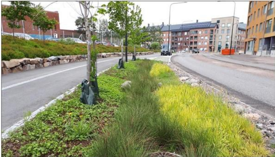
Kuva 10. Esimerkki biosuodatusrakenteesta (© Ramboll)
