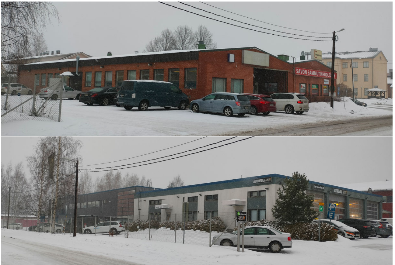
Kuva 3. Teollisuuskatu 1 (ylhällä) ja Teollisuuskatu 3-5 (alla).
